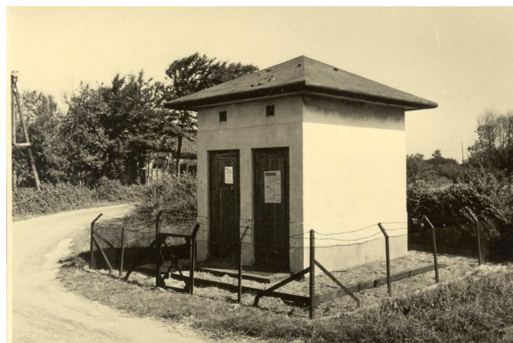
De eerste transformatorhuisjes
